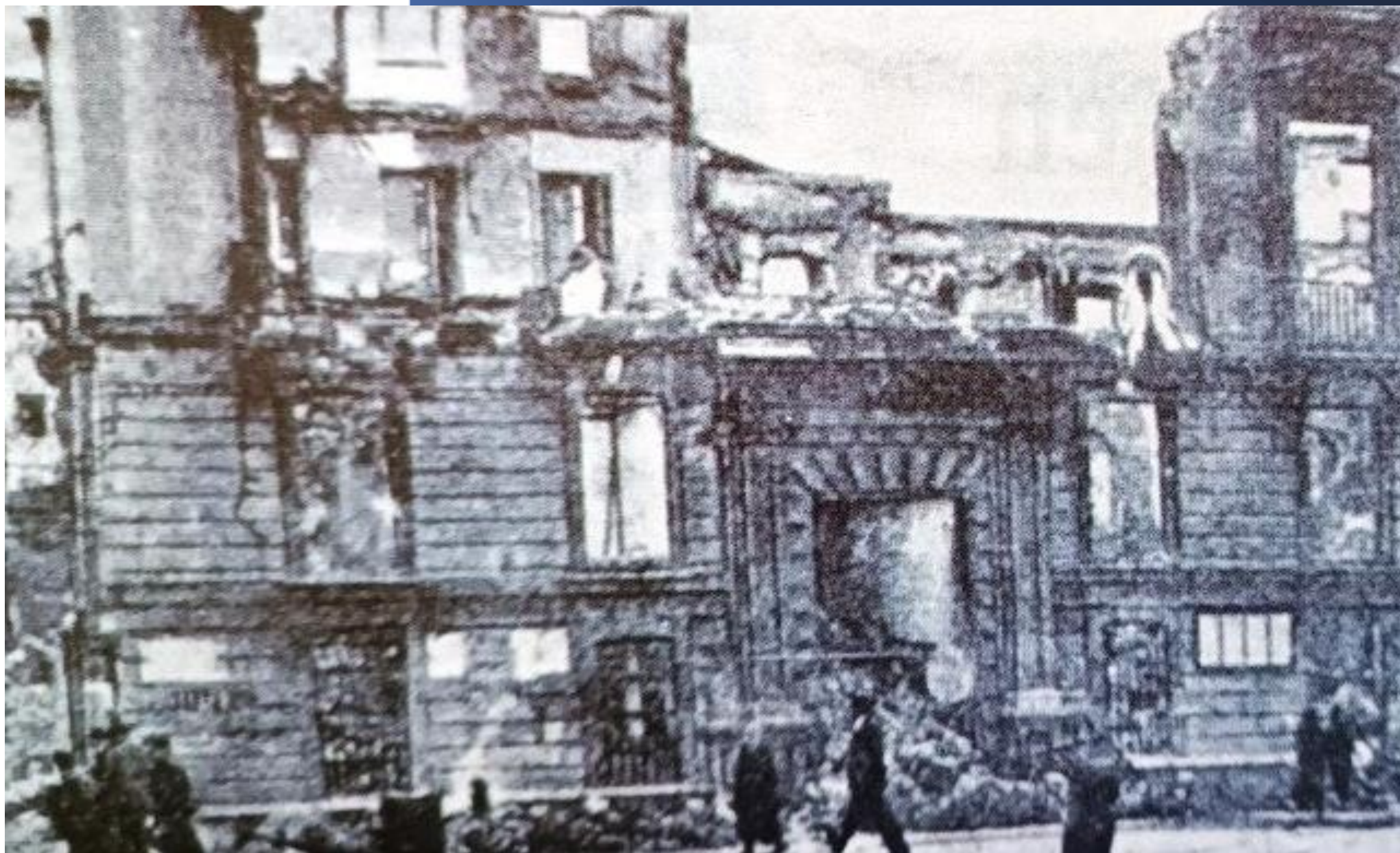
En febrero de 1937 el palacio de los Larios fue destruido e incendiado
